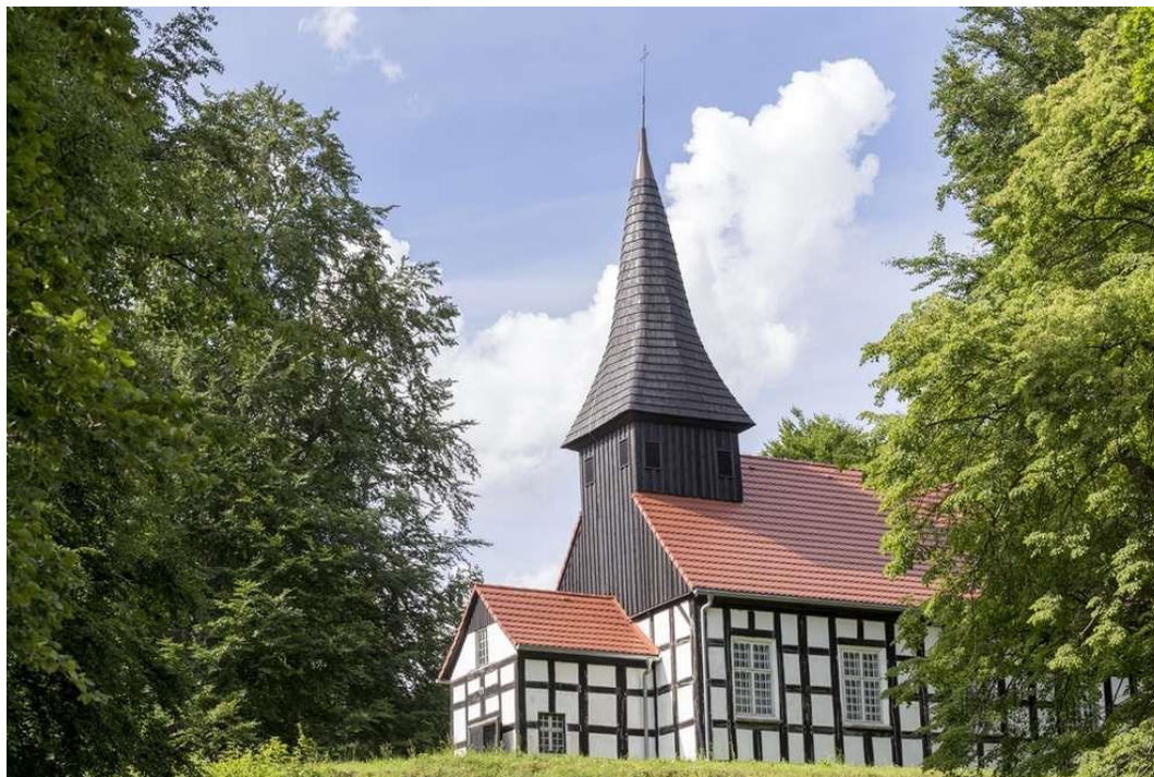
Fotografia 4. Kościół w Wałdowie
