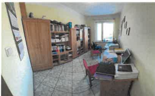
Fotografia 8. Remont pomieszczenia biurowego (PRZED)
