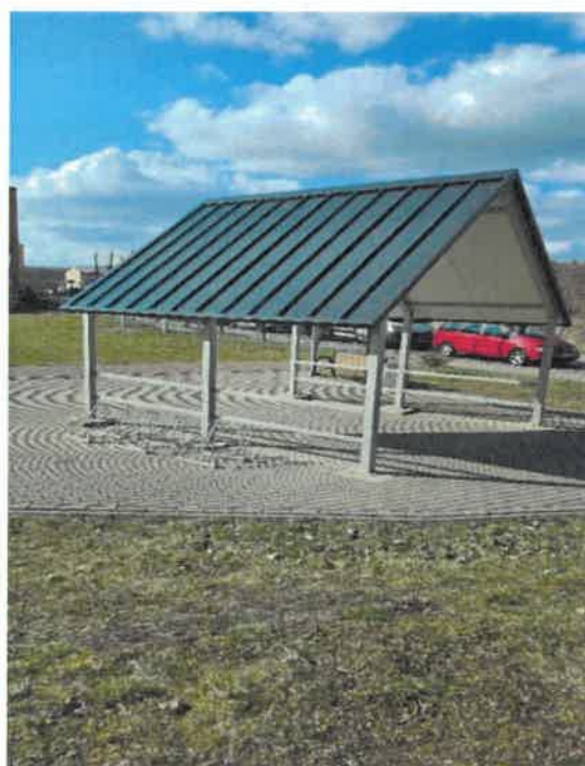
Fotografia 11. Remont wiat rekreacyjnych (PO)
