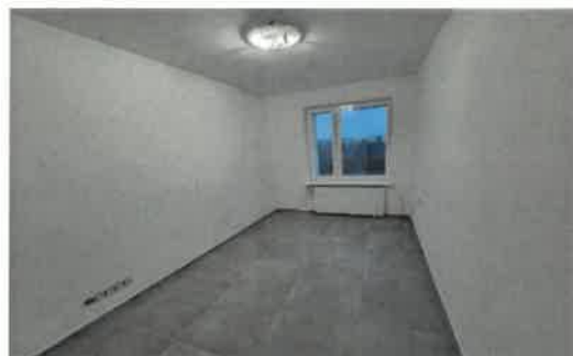
Fotografia 9. Remont pomieszczenia biurowego (PO)
