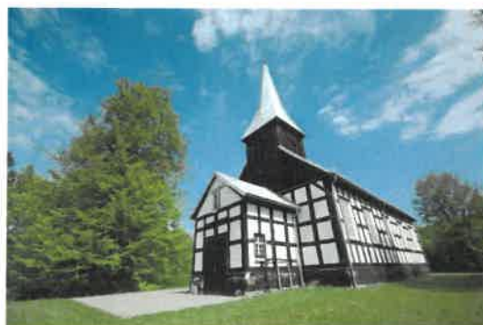
Fotografia 4. Kościół w Wałdowie
