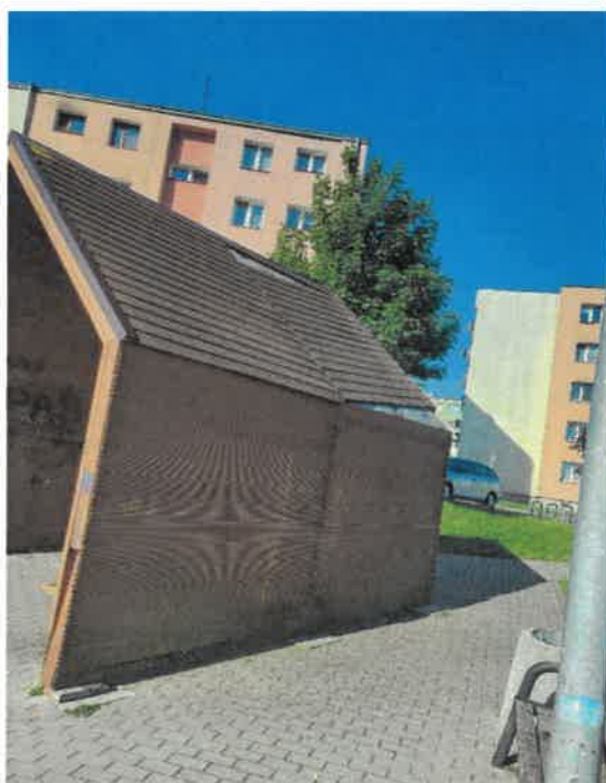
Fotografia 10. Remont wiat rekreacyjnych (PRZED)
