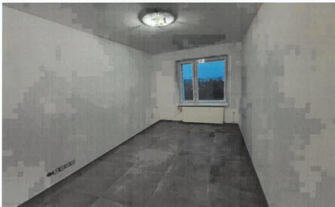
Remont pomieszczenia biurowego (PO)
