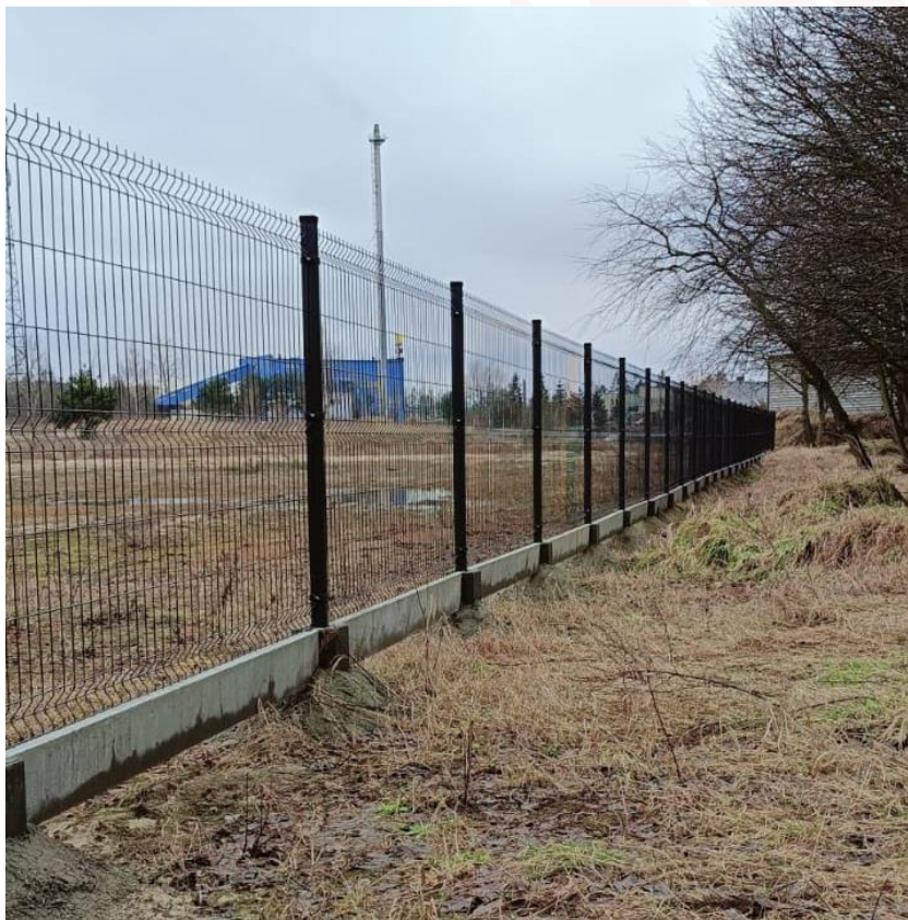
Fot. 36 Wymiana ogrodzenia KP PSP w Bytowie.
