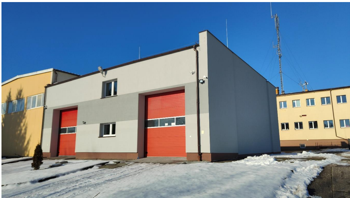
Fot. 30 Przebudowa budynku warsztatowo-magazynowego JRG Nr 2 w Miastku
