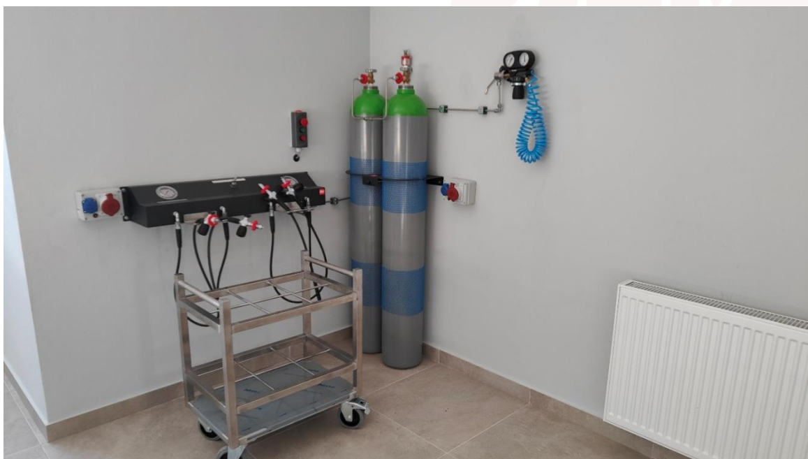
Fot. 33 Magazyn powietrza w budynku warsztatowo-magazynowego JRG Nr 2 w Miastku
