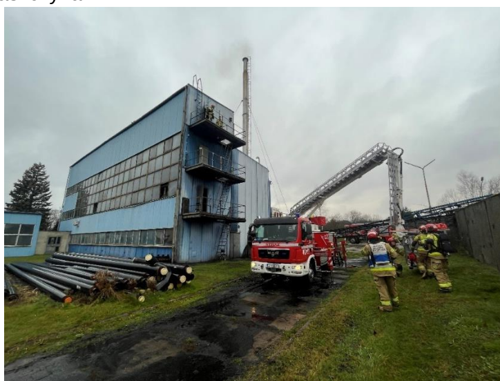
Fot. 20. Ćwiczenia „Zakład Energetyki Ciepłej”.
