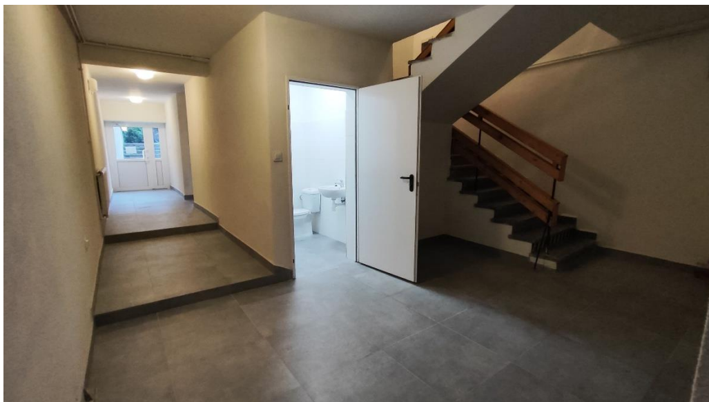
Fot. 34 Remont korytarza i sanitariatów sali gimnastycznej w Miastku
