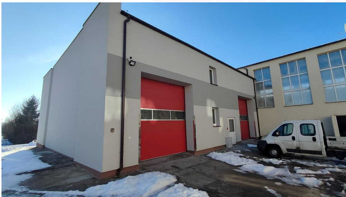
Fot. 29 Przebudowa budynku warsztatowo-magazynowego JRG Nr 2 w Miastku
