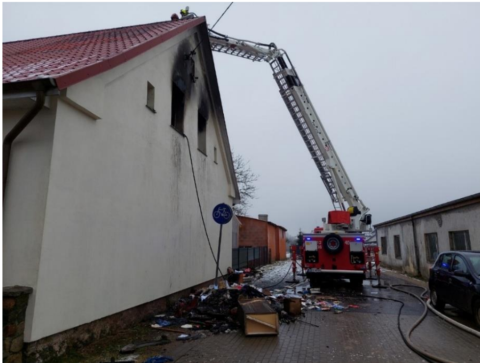
Fot 1. Pożar budynku jednorodzinnego.
