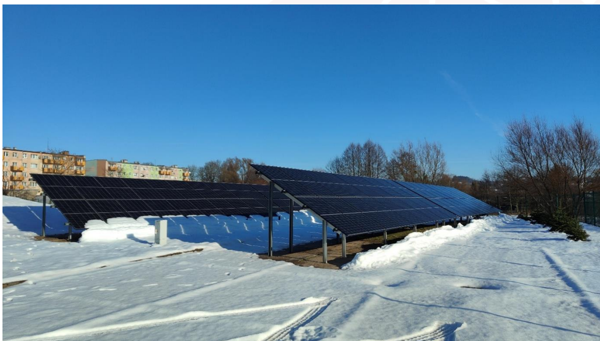
Fot. 31 Przebudowa budynku warsztatowo-magazynowego JRG Nr 2 w Miastku
